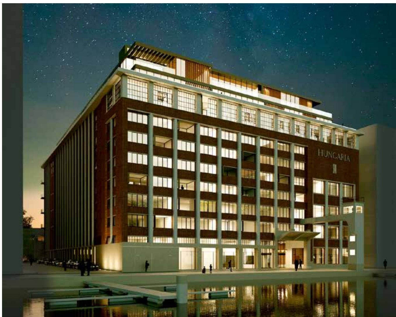
De renovatie van het gekende Hungaria-gebouw tot hip wooncomplex draagt bij tot een nieuwe, bruisende sfeer aan de Leuvense Vaartkom.
